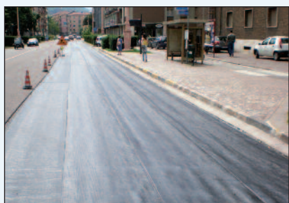
Figure 2 e 3 - L'applicazione della membrana Stratos ARS5 in corrispondenza delle fermate di autobus
