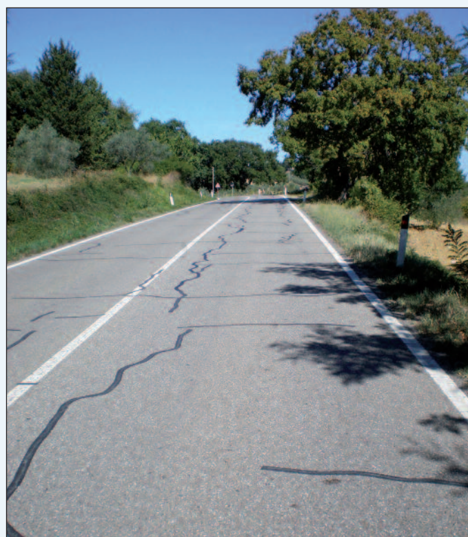
Figura 5 - L'applicazione dello Stratos ARS2 su un tratto ormaiato
